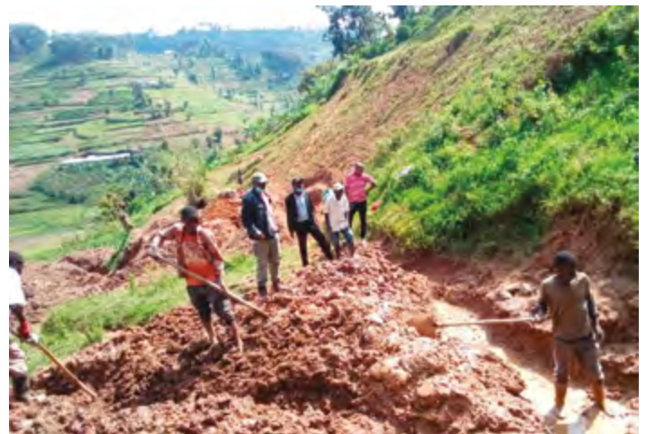
Creusement de canalisation au Rwanda
